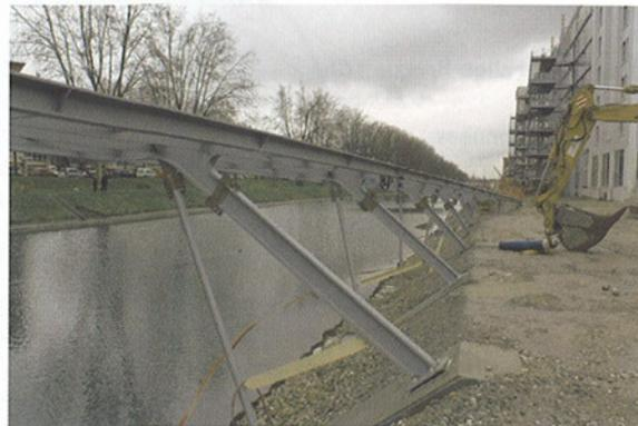
*Rampes posées prêtes pour la soudure définitive*
