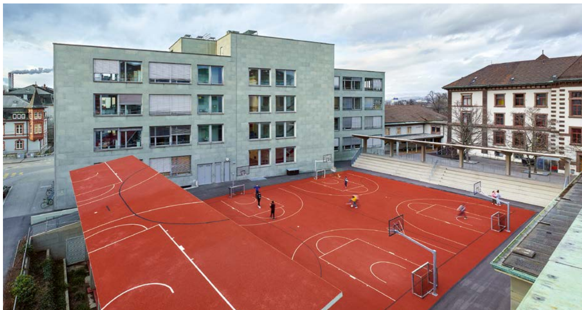
Gegen eindringende Feuchtigkeit und für eine attraktive Dachaufsicht erhielten die Tribürendächer denselben Kunststoffbelag wie die Basketballfelder.
